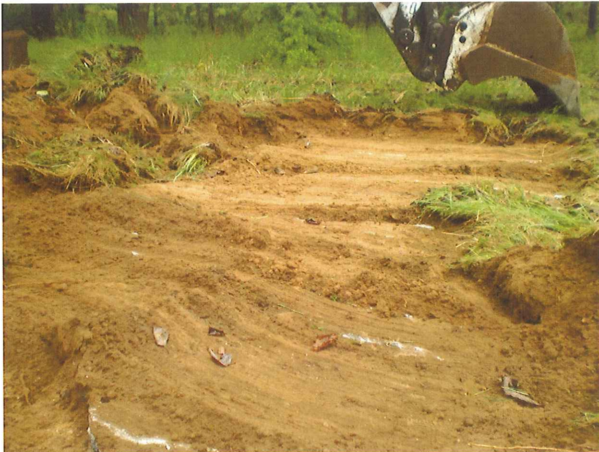
Fotografia nr 3. Odkrywanie studni pod wylewką betonową.
