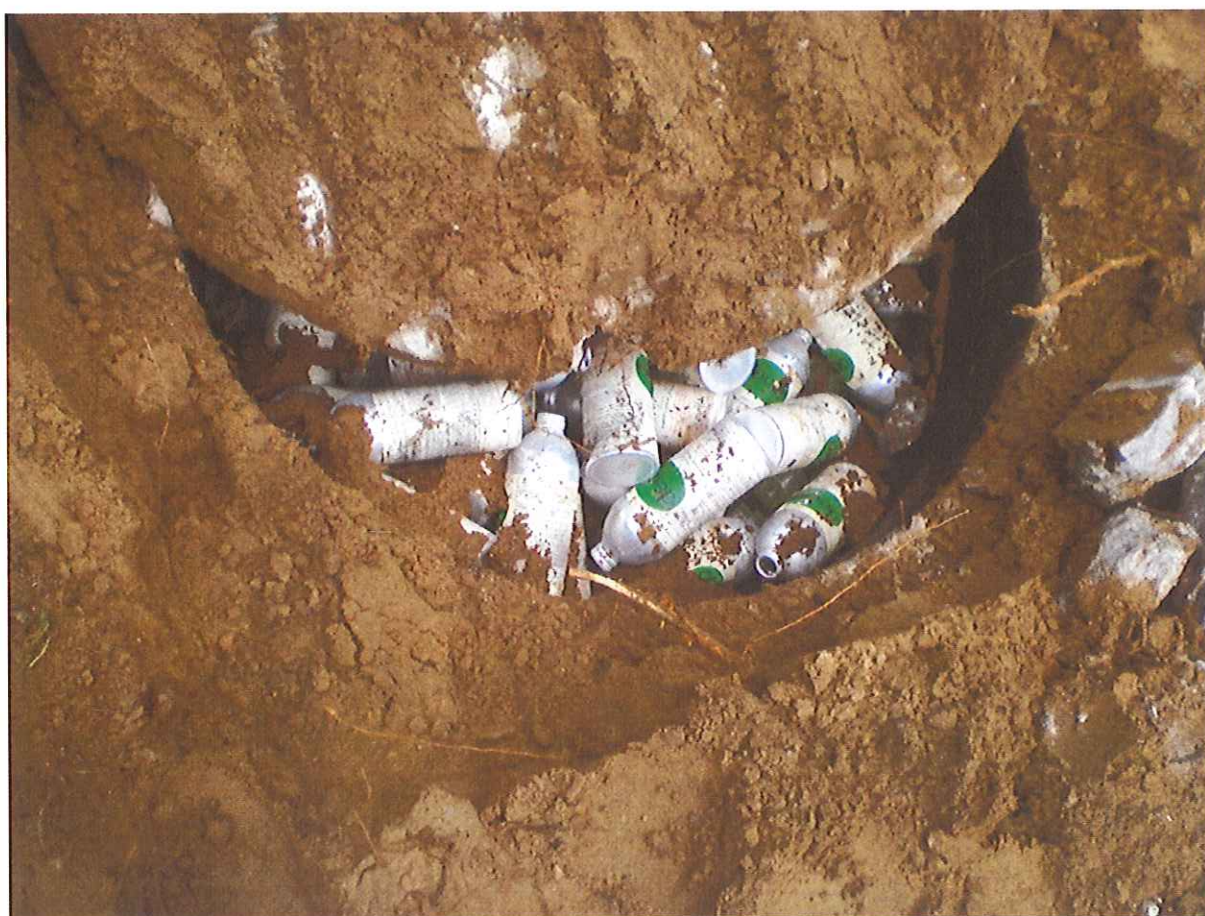
Fotografia nr 4. Wypełnienie studni pod płytą betonową.
