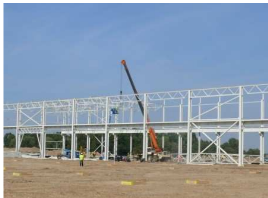
Budowa montowni maszyn w Stargardzie Szcz. 9 września 2009 r.
