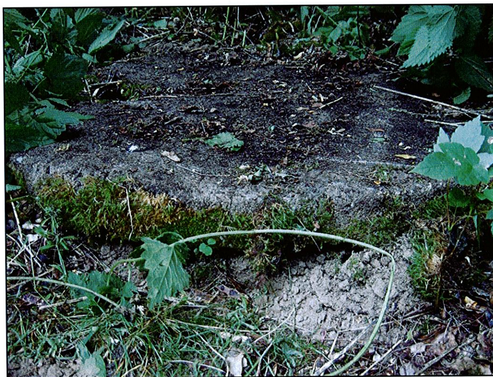
Fot. 6.: Zdjęta pokrywa studni nr 17 lub 18
