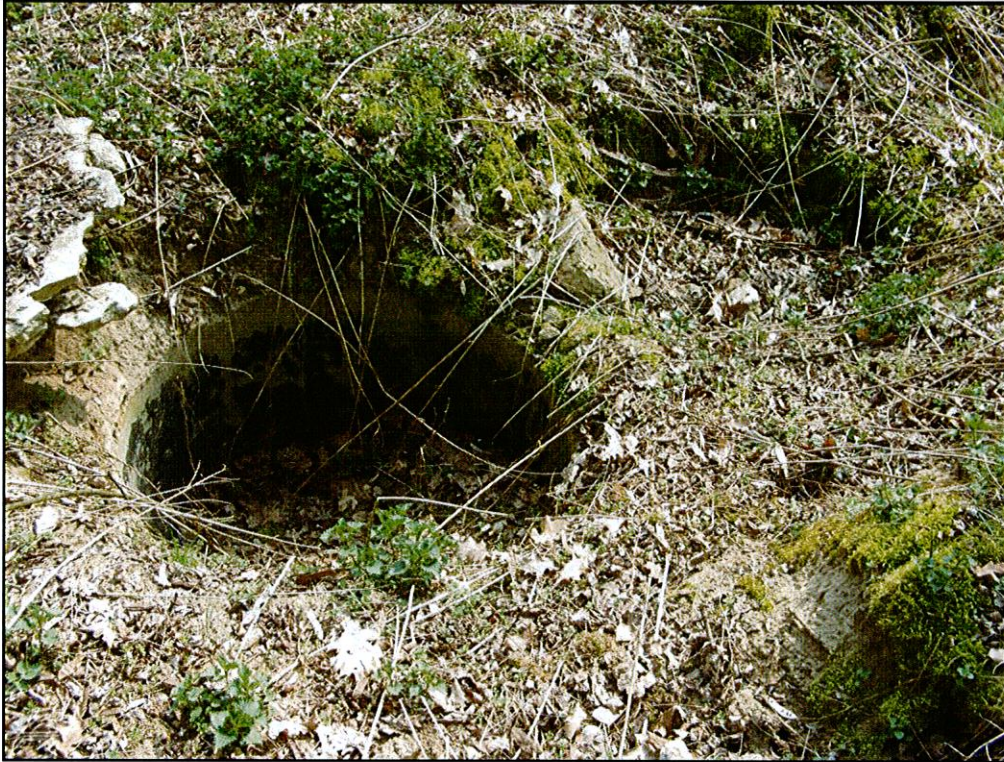
Fot. 7.: Studnie nr 21 i 20
