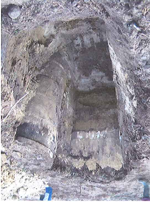
Wykop przy studni 21 (miejsce poboru próbki nr 1)
