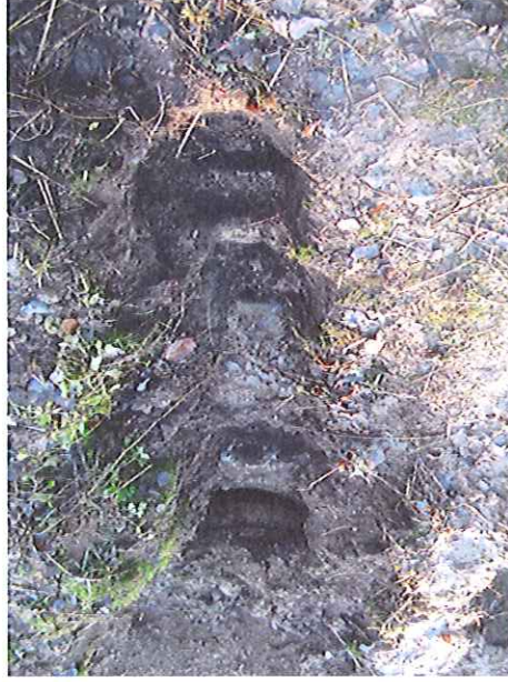
Wykop ziemny na kontakcie studni 5,7, i 9
