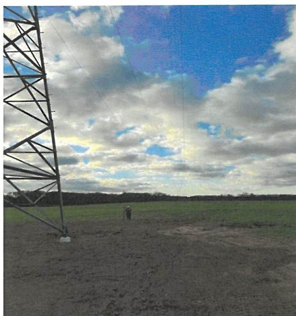
Badane przęsło nr 8 - 9
