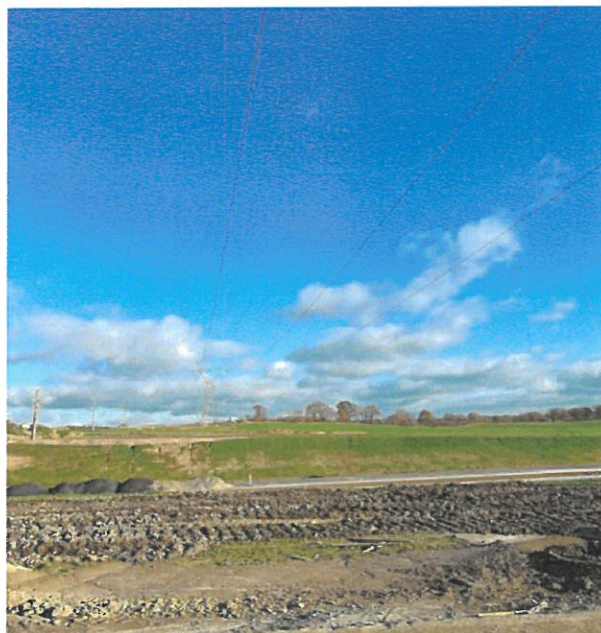
Badane przęsło nr 9 – 10, skrzyżowanie linii 220 kV z drogą lokalną
