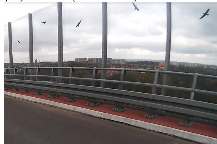
A6 (zabudowa za ekranem akustyczny na odcinku Radziszewo- Szczecin Kijewo)
