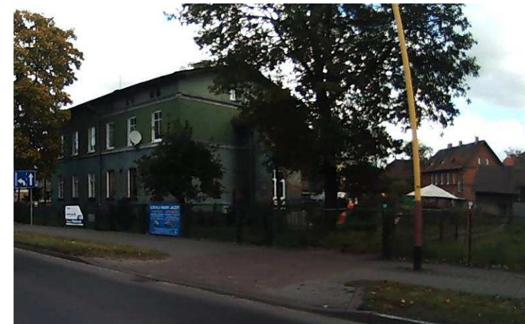
DK 11 (zabudowa na odcinku Szczecinek Przejsćie)
