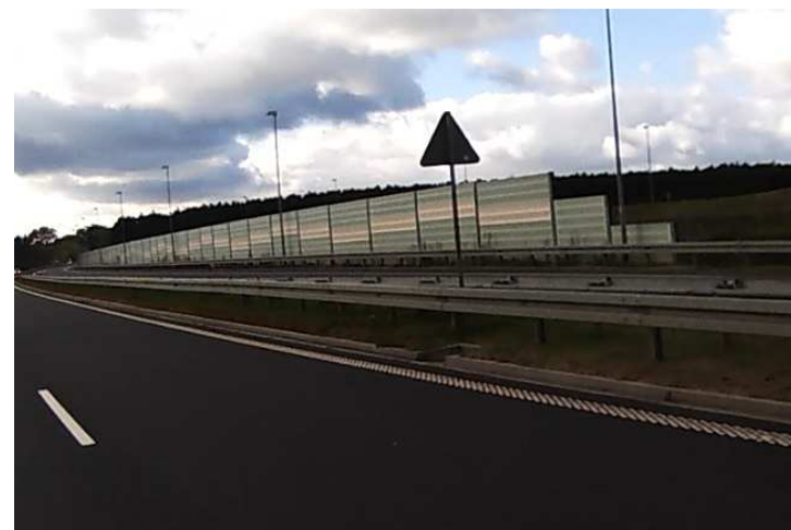
DK 10 i 10b (ekran akustyczny na odcinku Szczecin - Motaniec)
