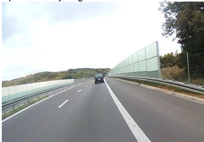
A6 (ekran akustyczny na odcinku Radziszewo- Szczecin Kijewo)
