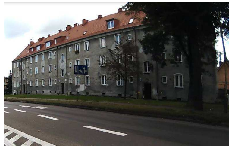
DK 11 (zabudowa na odcinku Szczecinek Przejsćie)
