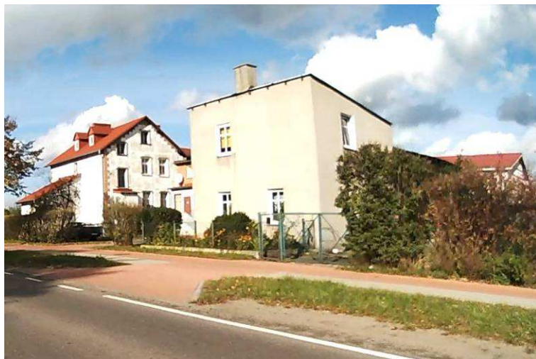
DK 11 (zabudowa na odcinku Szczecinek Przejsćie)
