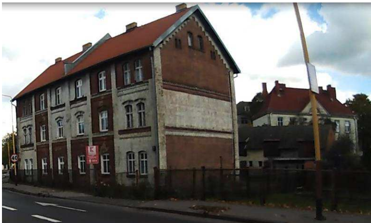
DK 11 (zabudowa na odcinku Szczecinek Przejsćie)
