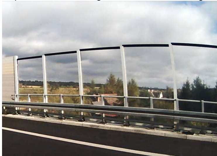
DK 3 i 3a (ekranowana zabudowa na odcinku Wolin - Pawłówek)
