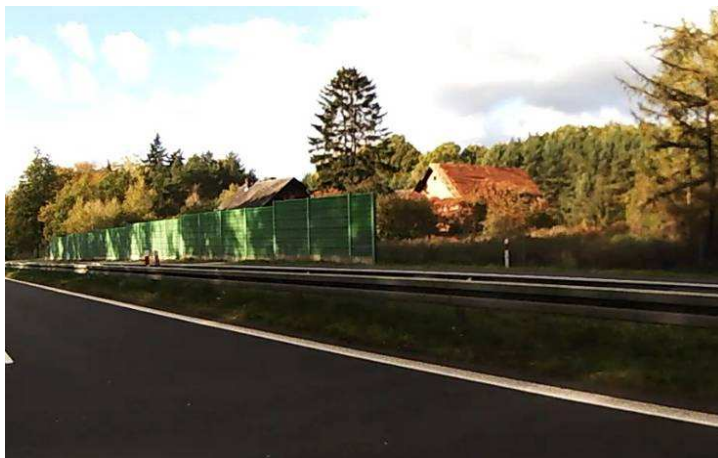
DK 10 i 10b (ekranowana zabudowa na odcinku Szczecin - Motaniec)
