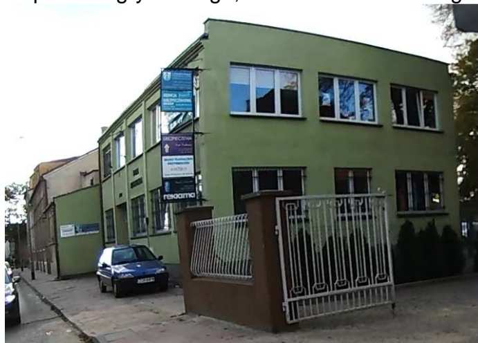
DK 31 (zabudowa na odcinku Radziszewo- Gryfino)
