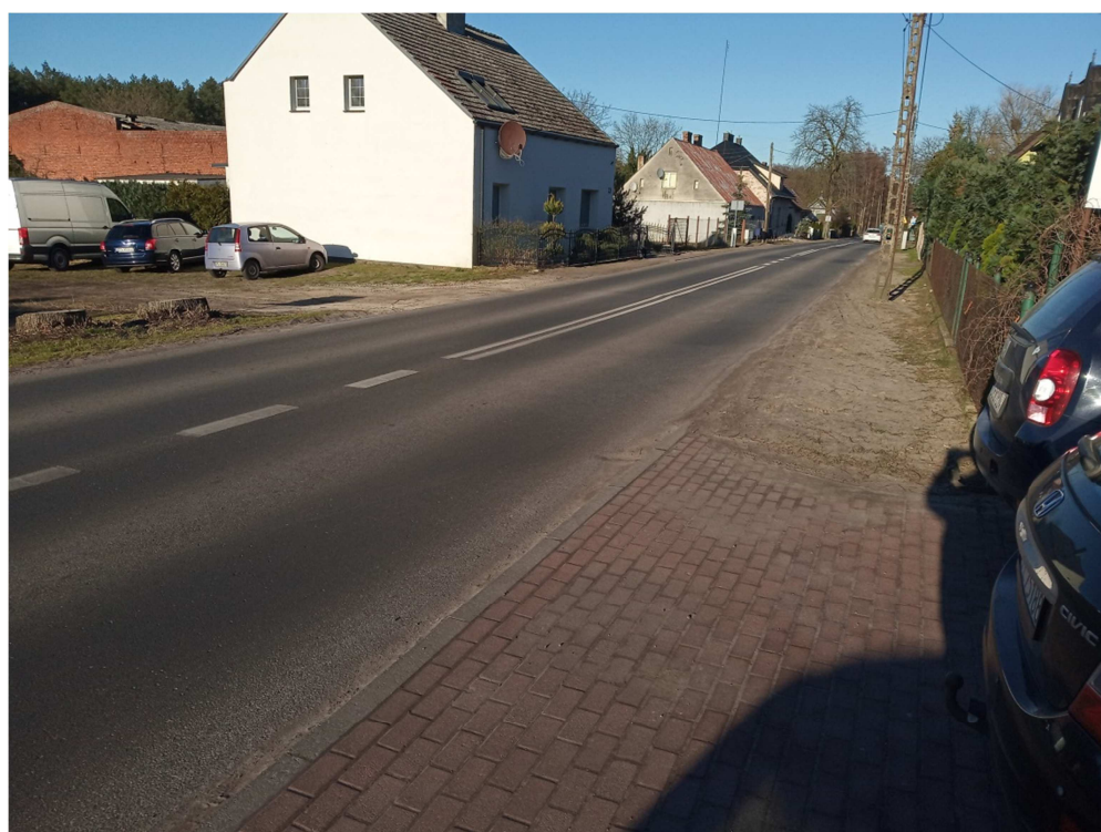
Rys. 8 Widok drogi powiatowej nr 3913Z w rejonie punktu pomiarowego P3.
