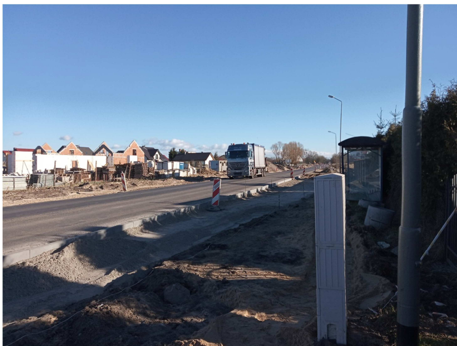
Rys. 6 Widok drogi powiatowej nr 3914Z w rejonie punktu pomiarowego P1.
