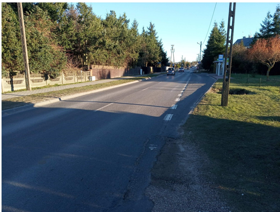
Rys. 9 Widok drogi powiatowej nr 3916Z w rejonie punktu pomiarowego P4.
