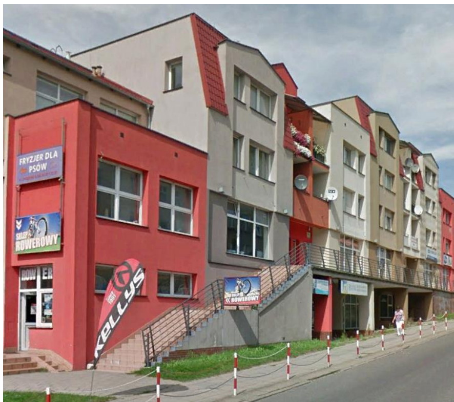
Przykładowa zabudowa na terenach mieszkaniowo – usługowych – droga powiatowa P5520Z, ulica Młyńska
