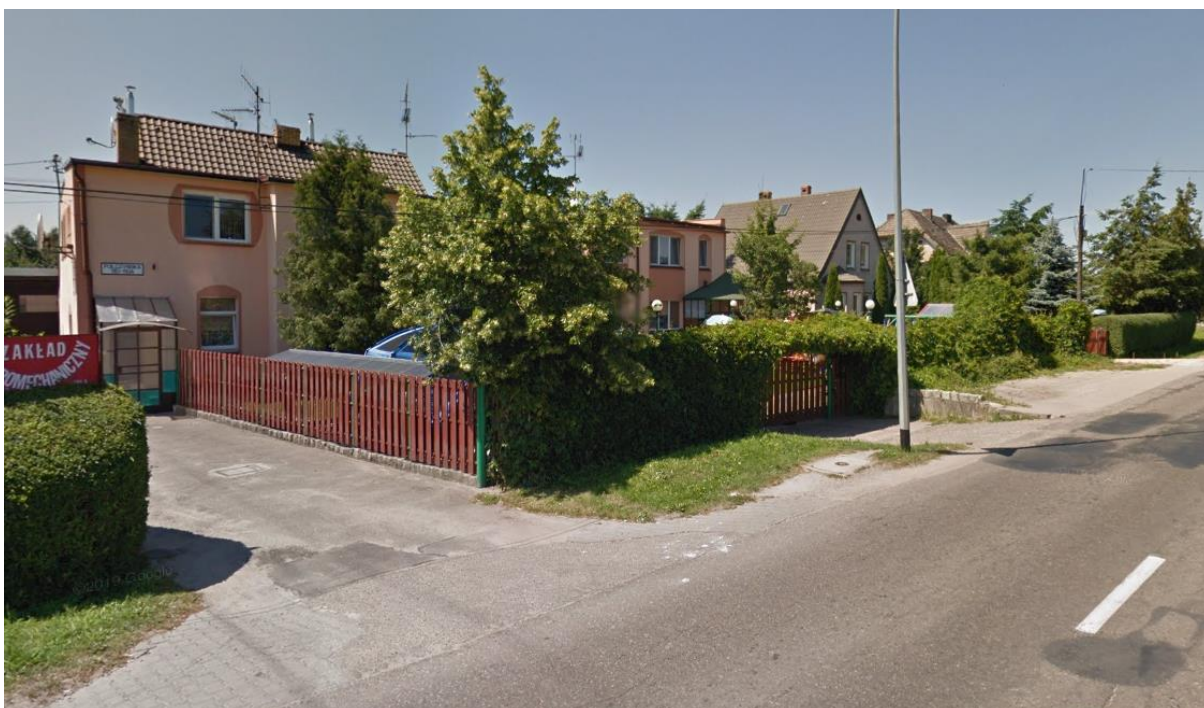
Przykładowa zabudowa na terenach zabudowy mieszkaniowej jednorodzinnej – droga wojewódzka 167, ulica Polczyńska
