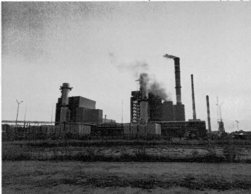
Zdjęcie nr 1. Przedpole 400 kV Transformatorów Blokowych 09BAT10, 10BAT10 – widok fragmentu obiektu.
