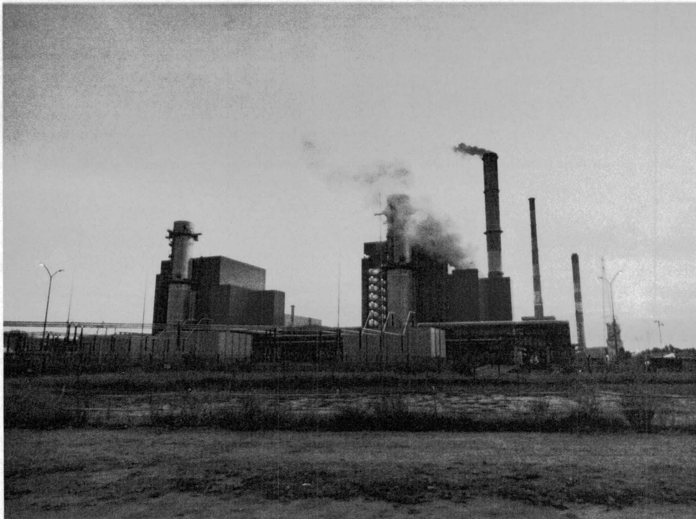
Zdjęcie nr 1. Parking pracowników budowy elektrowni – punkt pomiarowy nr 2.
