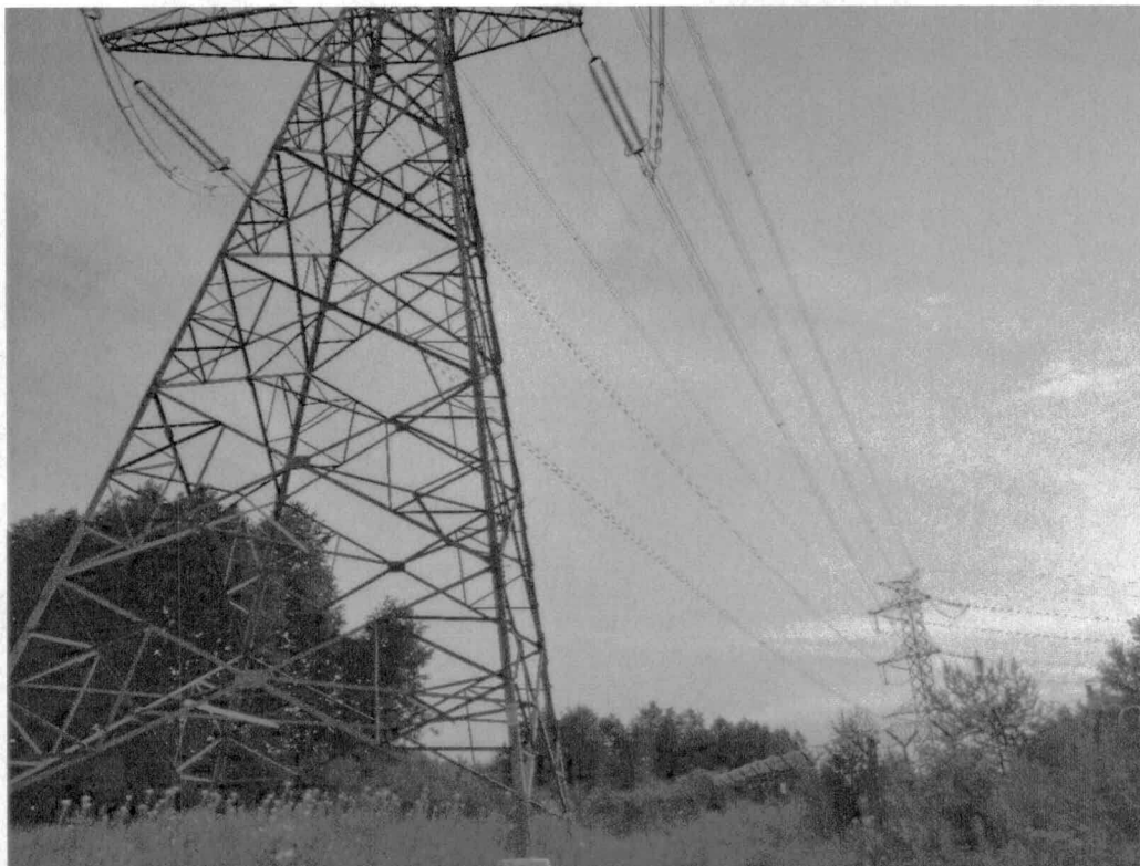
Zdjęcie nr 3. Przęsło Słup nr 1 i nr 2 napowietrznej dwutorowej linii 2 x 400 kV – dla układu wyprowadzenia mocy do sieci elektroenergetycznej bloków nr 9 i 10 – widok fragmentu obiektu.
