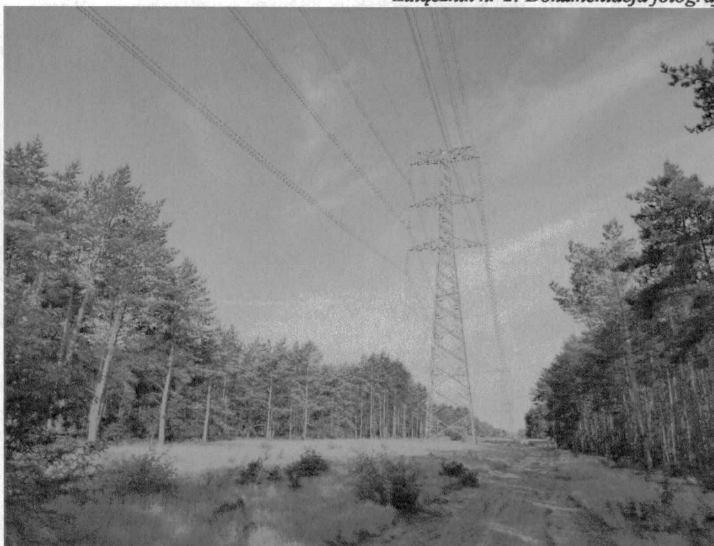
Zdjęcie nr 1. Słup nr 5 napowietrznej dwutorowej linii 2 x 400 kV – dla układu wyprowadzenia mocy do sieci elektroenergetycznej bloków nr 9 i 10 – widok fragmentu obiektu.
