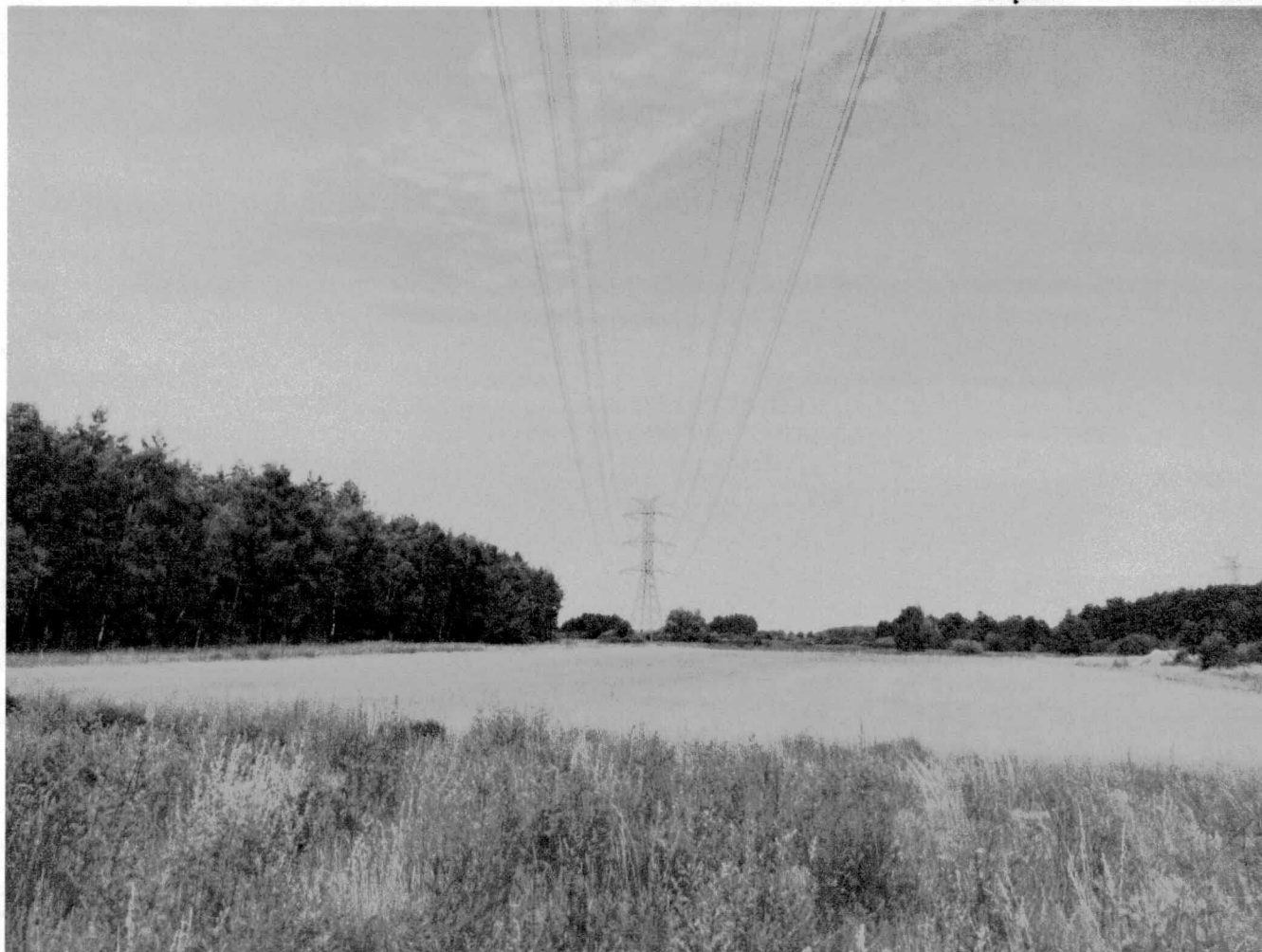
Zdjęcie nr 1. Widok na przęsło słupów nr 3 – 4 (widoczny słup nr 3) – punkt pomiarowy nr 3.
