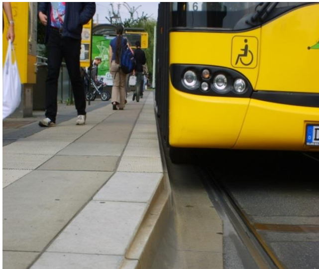
Rys. 9.5.2.1. Zalecane ukształtowanie krawędzi peronowej. Źródło: materiały własne.
