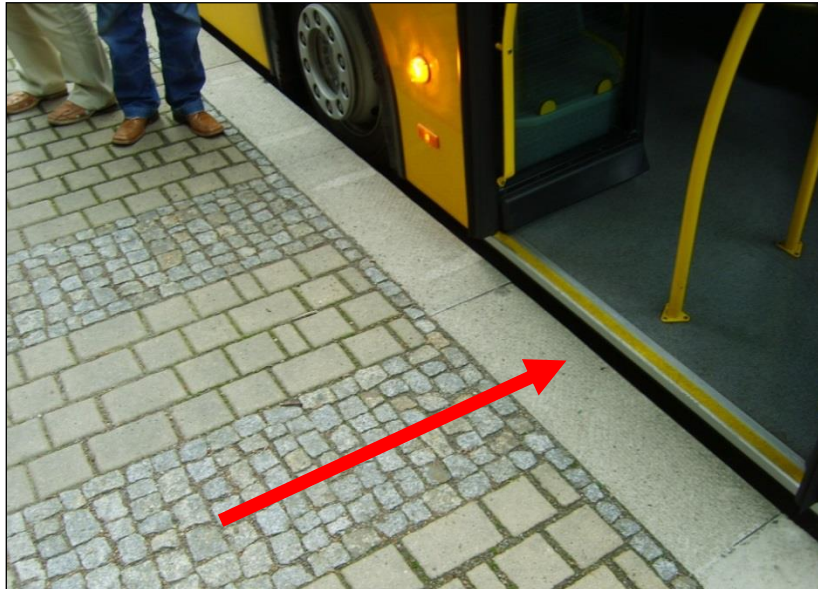
Rys. 9.5.2.3. Strefa wejściowa – inny rodzaj nawierzchni naprzeciwko pierwszych drzwi autobusu. Źródło: materiały własne.
