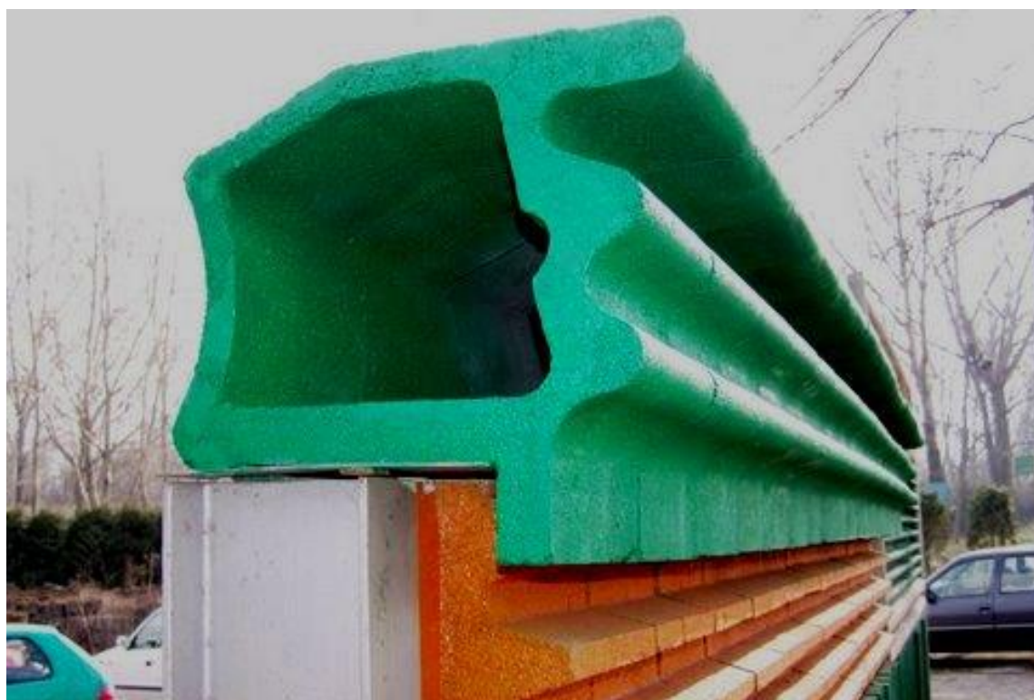
Rysunek 14-8 Dyfraktor zamontowany na krawędzi górnej ekranu akustycznego
