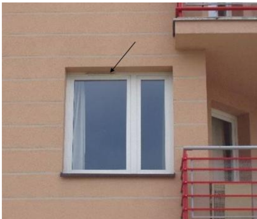
Rysunek 14-14 Okno dźwiękoszczelne z nawiewnikiem
